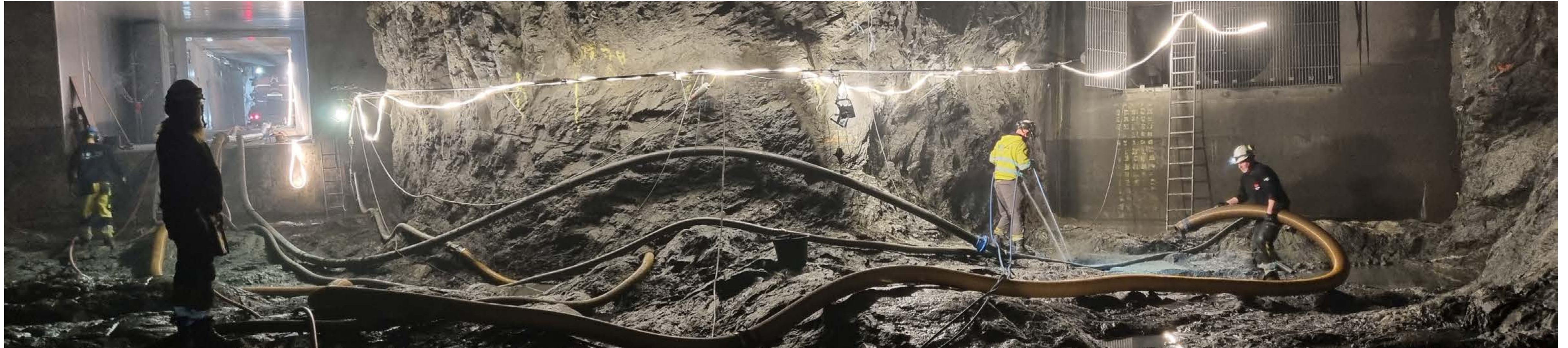
Tilløpstunnelen og delar av utløpstunnelen i Løkjelsvatn kraftverk i Etne blei spylereinska og slamsugd før dei blei fylt med vatn.
