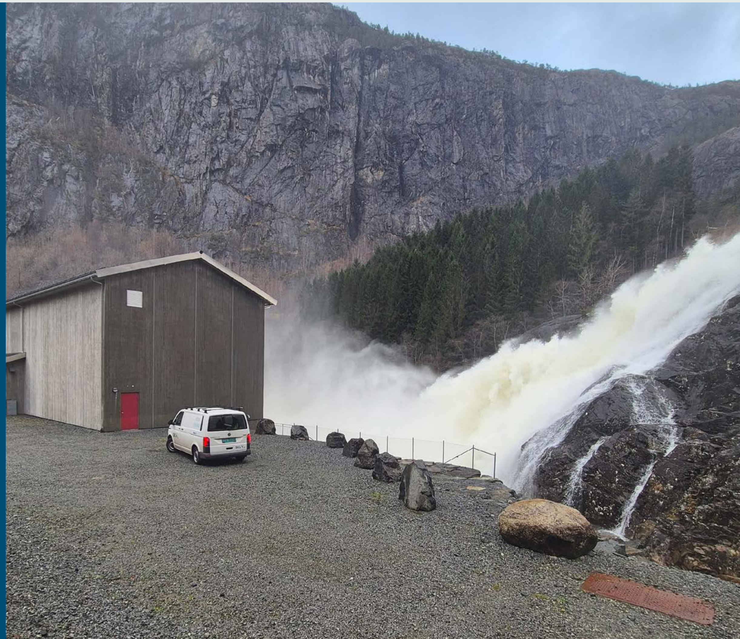
Håfoss Kraftverk i Etne kommune.
