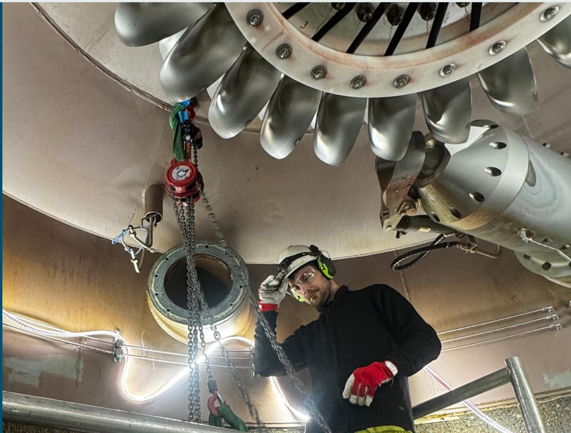
Utskifting av ei dyse på turbinen i Tverrelva kraftverk i Kvinnherad kommune.
