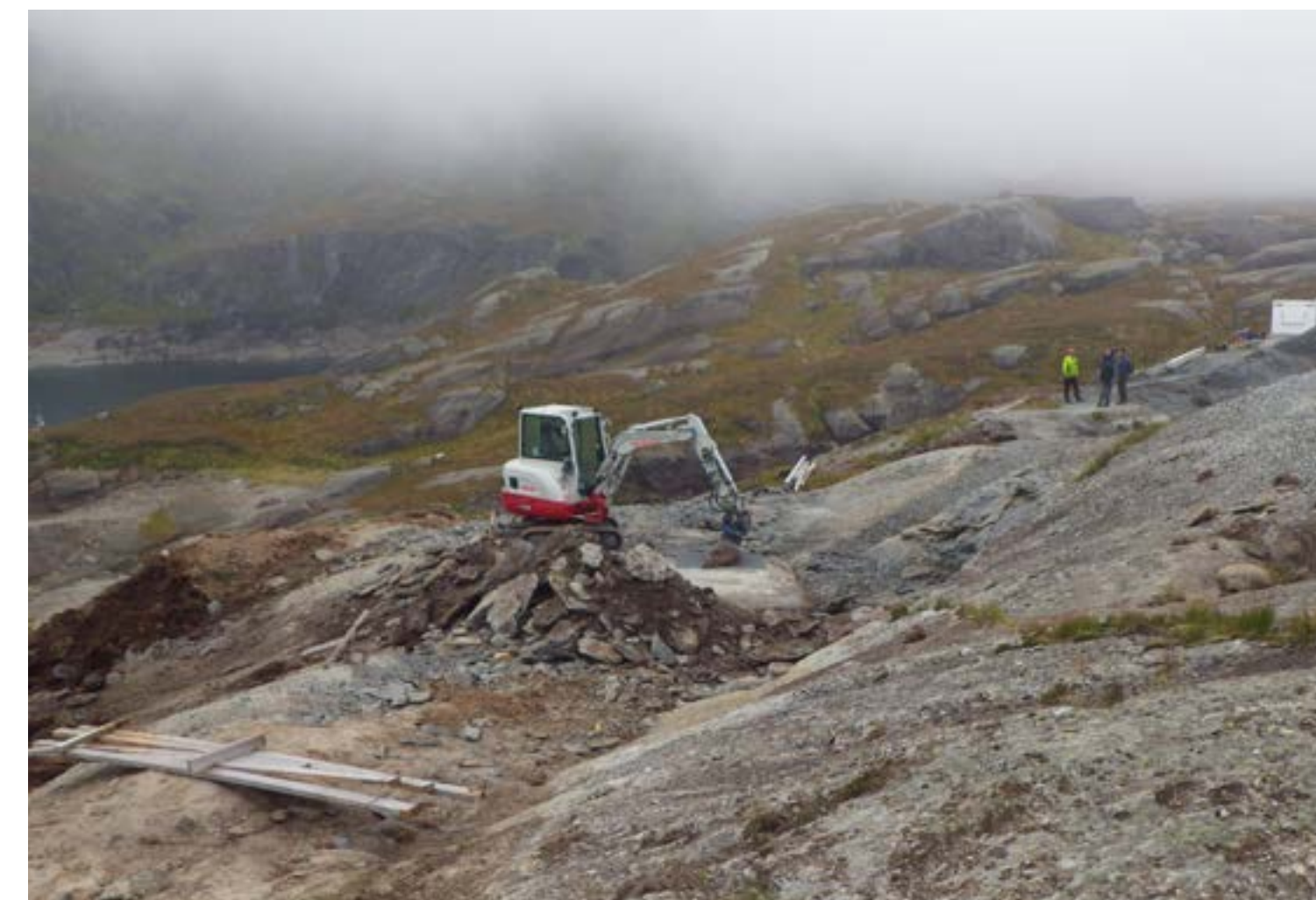
Riggområde boresjakt inntak Løkjelsvatn 2021
