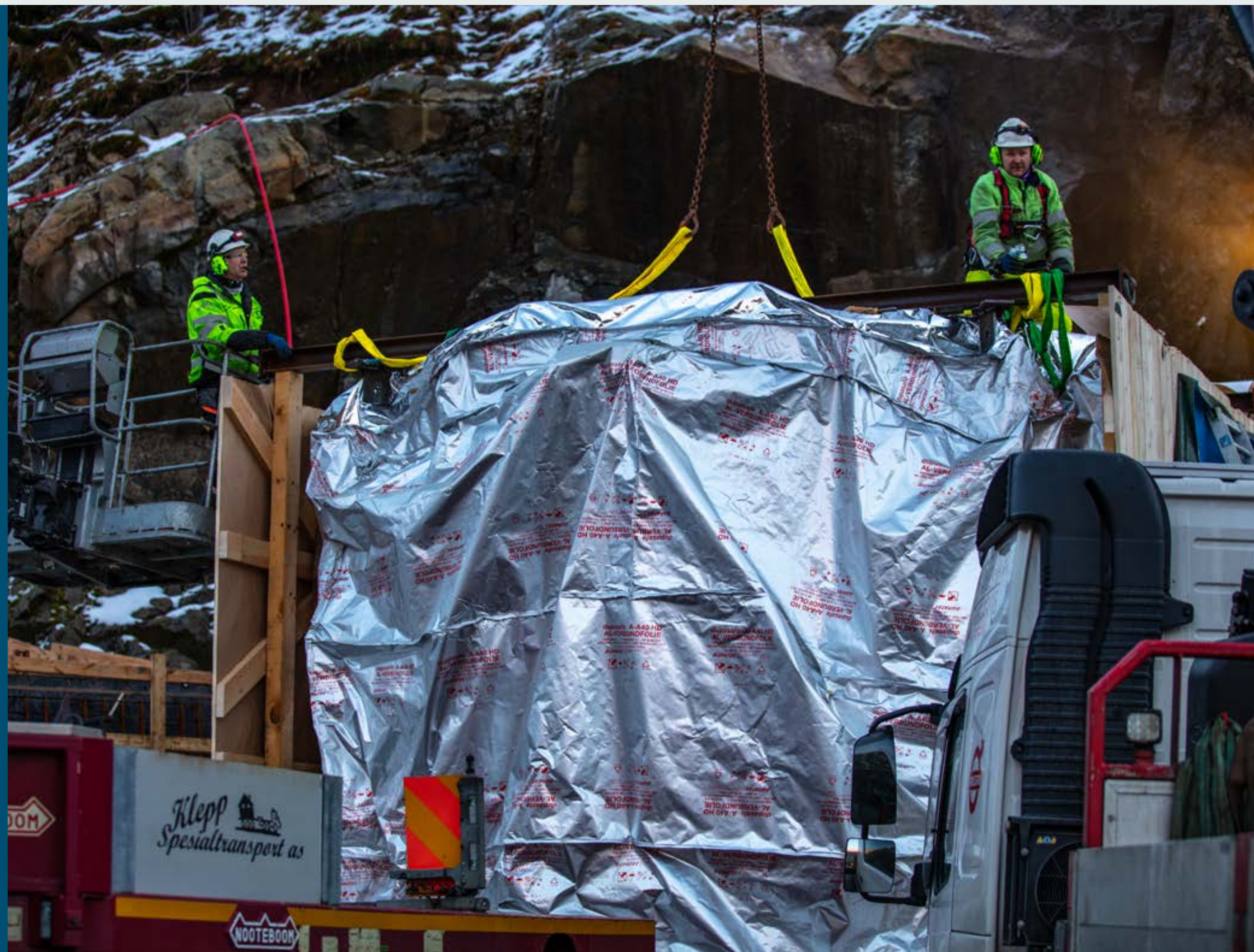
Ny stator vert transportert inn i Løkjelsvatn kraftverk februar 2022. Her skal me produsera 163 GWh./år
